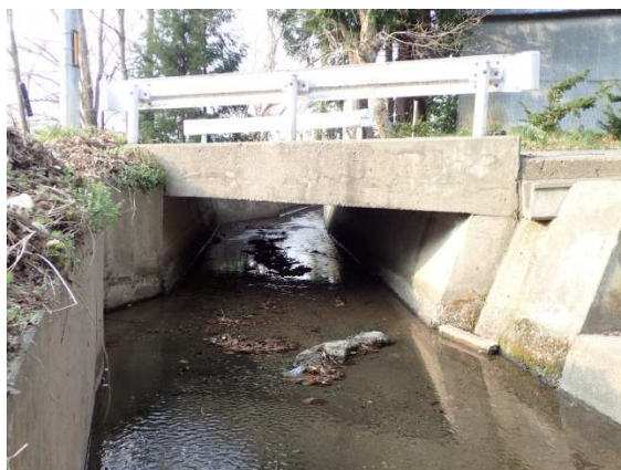
四ツ石田茂木野 1 号橋
