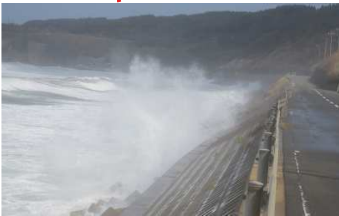
※高波による交通障害写真
