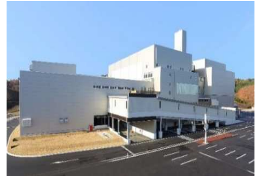
青森市清掃工場 外観
