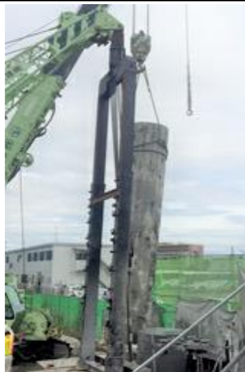
コンクリート製杭抜き
