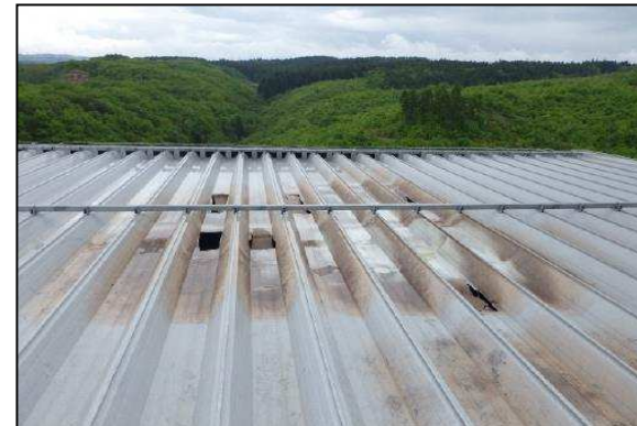
②破碎選別処理施設屋根（選別室屋根）
