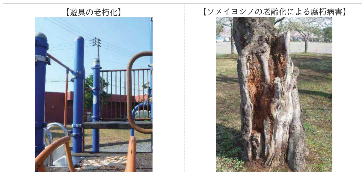
図 参考 16 遊具の老朽化・公園樹の老齢化
