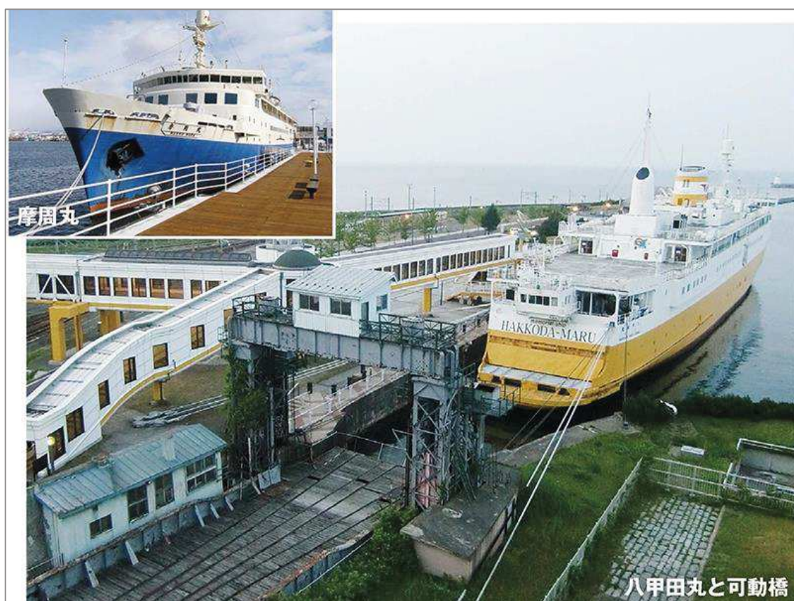
図 参考 45 青函連絡船及び可動橋
