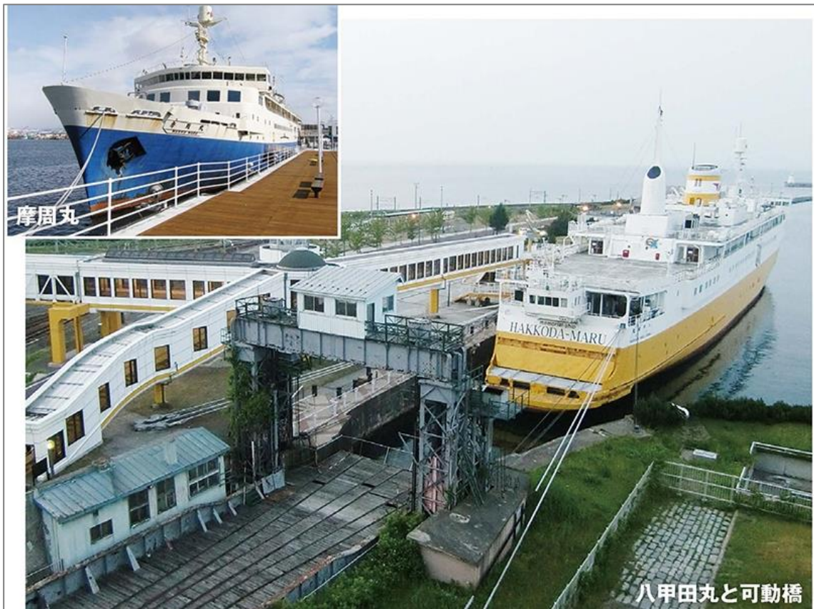
図 参考 45 青函連絡船及び可動橋
