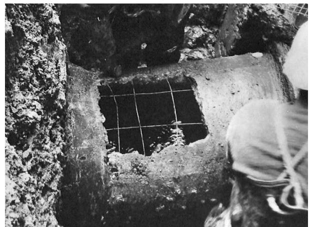
十勝沖地震※による導水管※の破損
