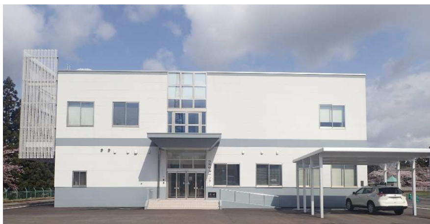
横内浄水場 水質管理センター
