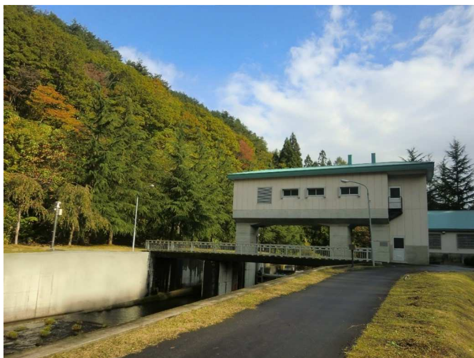
横内浄水場水源地 (取水施設)
