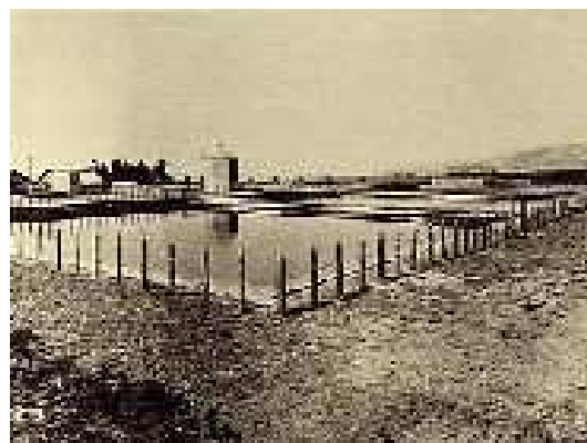
大正時代の横内浄水場
