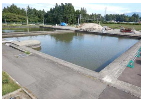
北系ろ過池（左端1号池、中央2号池）
