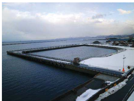
図 73 青森港本港地区緑地（浜町） 雪処理施設
