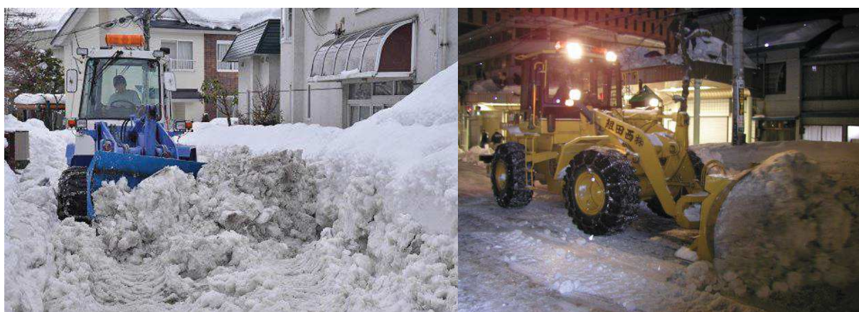
図 78 除排雪作業の様子
