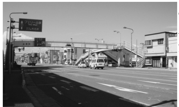
〈国道7号線に設置されている上古川歩道橋〉
