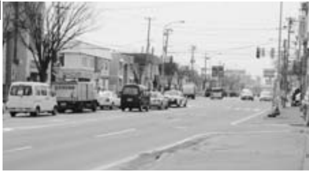
〈右折車両の矢印信号設置が望まれる中央大橋南側交差点付近〉
