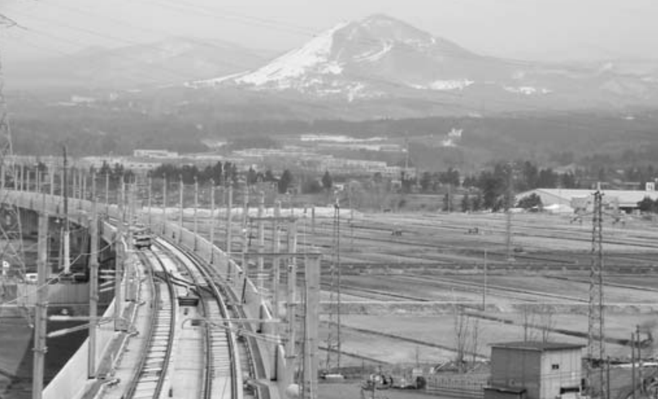
〈平成22年度開業に向け急ピッチで工事が進められている東北新幹線八戸—新青森間工事 ～スカイブリッジから見る青森市～〉
