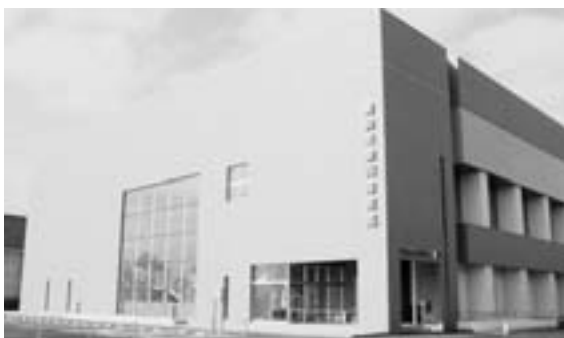
〈平成20年2月に完成した浪岡体育館〉
