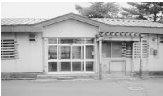
〈現在地元住民が集会所などとして使用している旧奥野区画整理事務所〉
