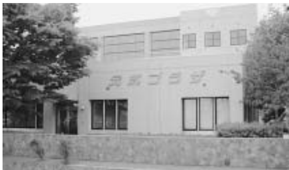
〈敷地内に2階建ての建物を建築し、市保健所機能を集約する予定の元気プラザ〉
