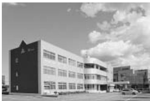
(国からの建物の無償譲渡が決まったあおもりコンピュータ・カレッジ)
