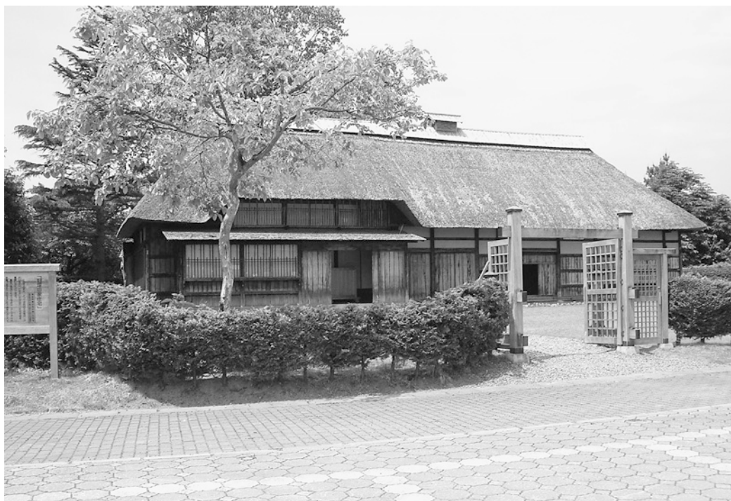
〈浪岡中世の館に隣接する旧坪田家住宅。農家と茶屋の両方の名残を留める江戸時代の津軽を代表する住宅建築で、平成14年に県重宝に指定された。〉
