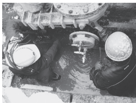
〈施工に係る技術的な指導・監督を行う水道部職員 (左側)〉
