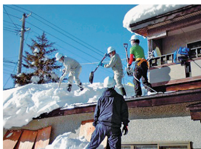
〈スノーレスキュー隊による屋根の雪下ろし〉
