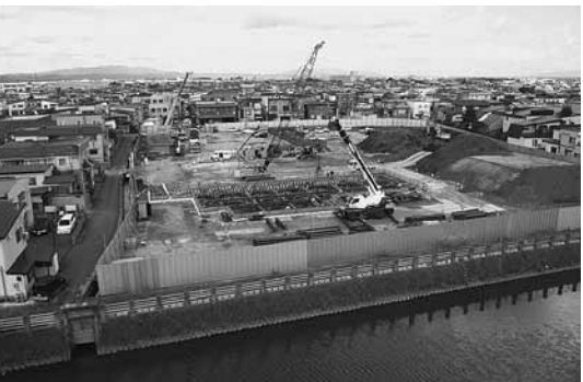
〈現在、建設工事が進められている富田ポンプ場の様子〉
