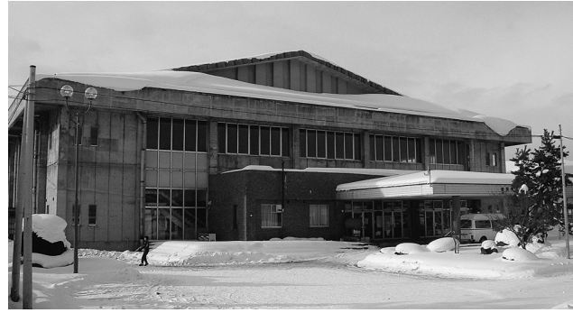
〈アスベスト調査の結果により利用中止となっている旧浪岡町民体育館〉
