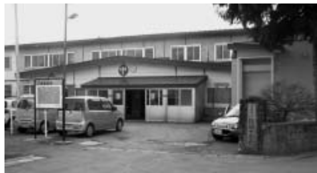
〈平成19年度からの改築工事が計画されている新城中学校〉
