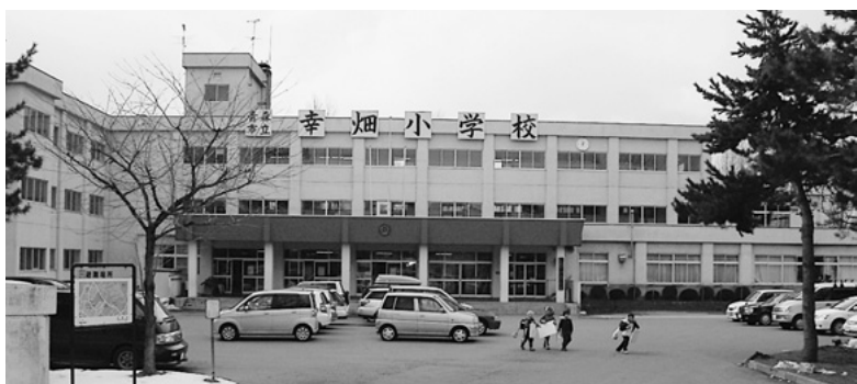
〈耐震診断を経て耐震改修工事を終えた幸畑小学校〉
