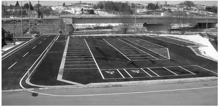
〈外構工事が進められる浪岡駅西口駐車場〉
