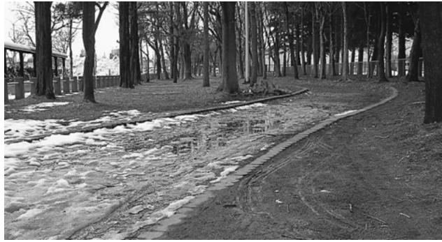
〈水たまりができて通行に支障を来している県病横の遊歩道〉
