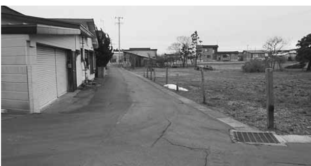
大雨により床下浸水するなど、水害の常襲地域である清水字浜元51番地付近
