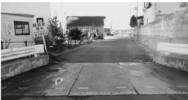
大雨により道路冠水が発生した、羽白字富田の北高校前バス停留所付近
