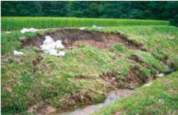
〈台風第7号の被害により崩落した田及び水路のり面（写真は沢山地区）〉
