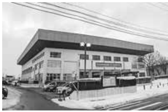
〈開館から約40年間経過している市民体育館〉
