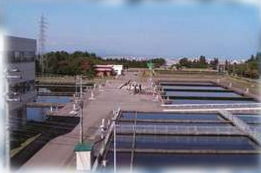
横内浄水場 じょうすいじょう (沈殿池 ちんでんち ・ろ過池 ろかち )
