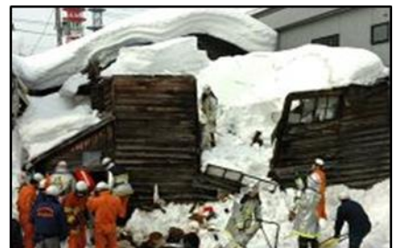
【雪の重みで倒壊した家屋】
