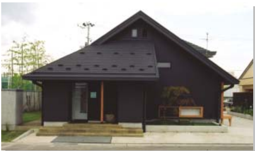
軒先つらら防止雨樋工法が使われている展示場です。
