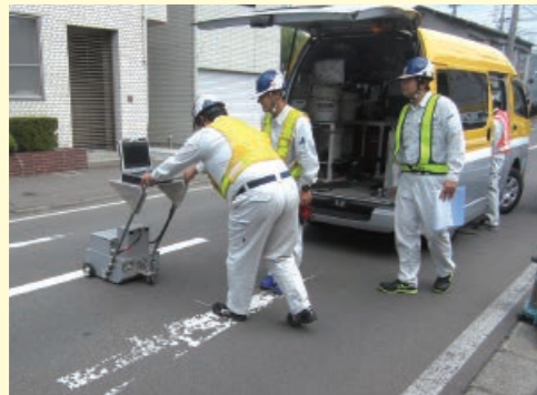
路面下空洞調査
