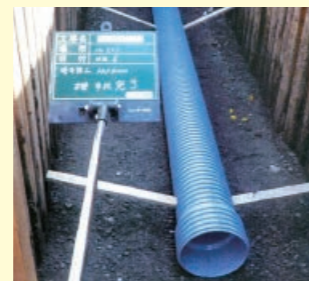
下水道管布設工事の様子
