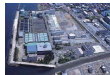
八重田浄化センター
