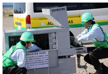
・ライフライン応急復旧訓練 （青森ガス(株)）
