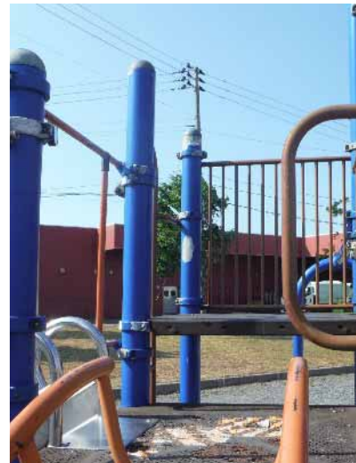
〈ベータタウン沖館公園の遊具の老朽化〉
