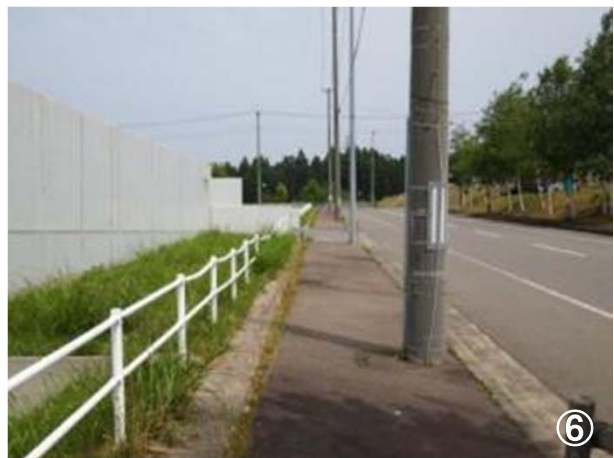
中学校給食センター南東側道路(北東向き)
