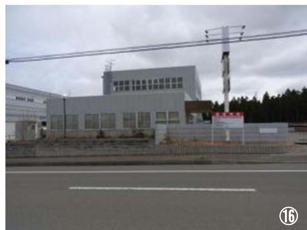
計画地より北東面を見る
