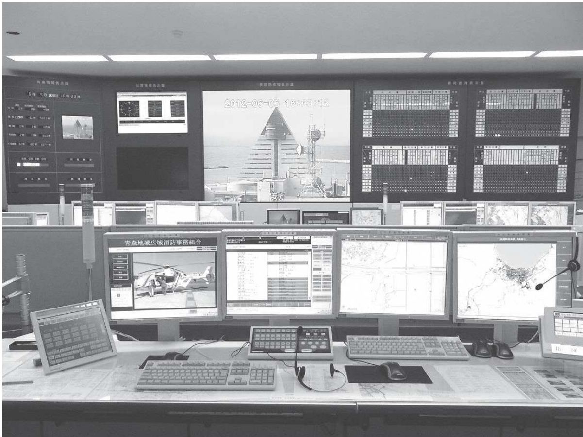
高機能消防指令システム
