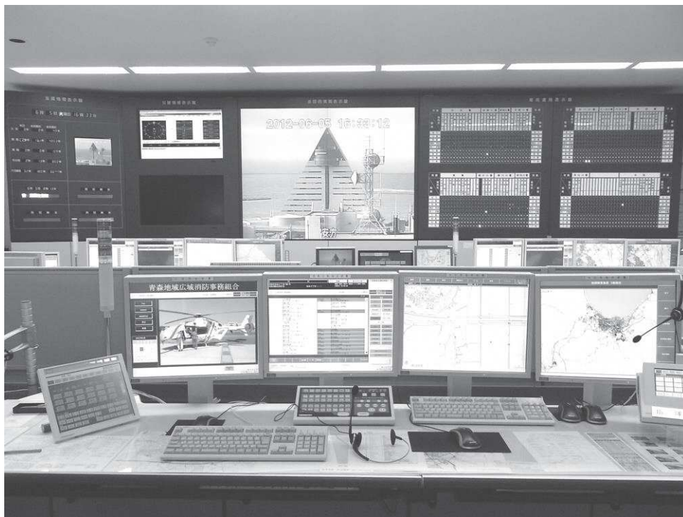
高機能消防指令システム
