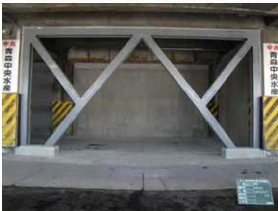
(平成 22 年度 市場棟耐震補強工事)
