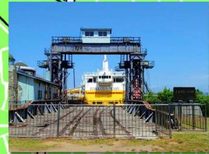
i 青函連絡船可動橋（2016年5月26日撮影）
