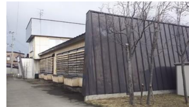
造道福祉館（現況）
