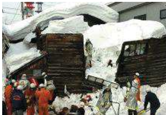
図 24 雪の重みで倒壊した家屋
