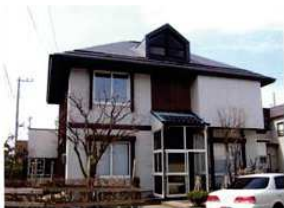
図 67 住宅（無落雪屋根への改修前）
