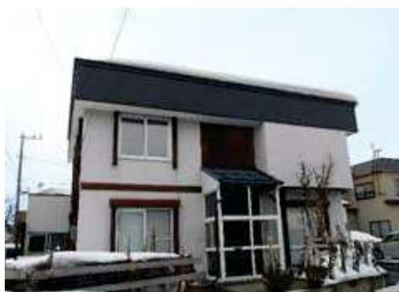
図 68 住宅（無落雪屋根への改修後）
