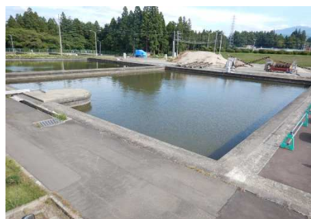
北系ろ過池（左端1号池、中央2号池）
