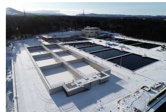
横内浄水場北系沈殿池の耐震化（R2年度）
