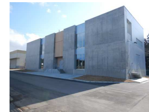
横内浄水場紫外線処理施設の導入（R3年度）
