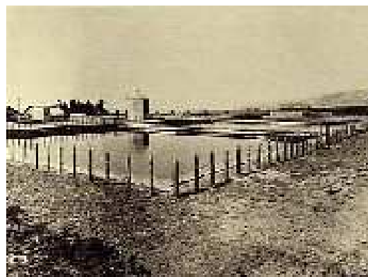
大正時代の横内浄水場
