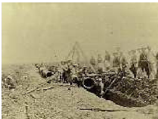
創設時の配水管の布設
