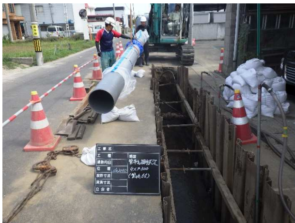
管路の耐震化工事
