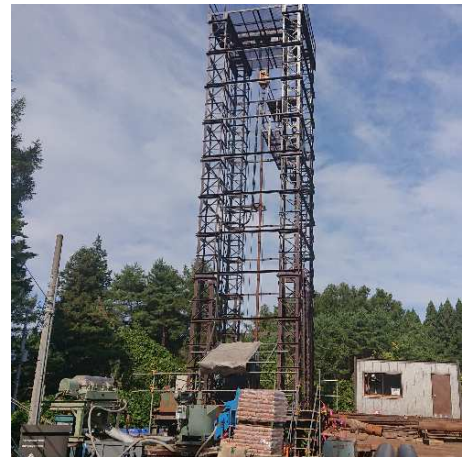
天田内取水井更新事業
