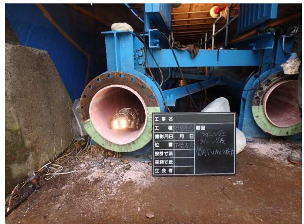
水管橋の更生工事
