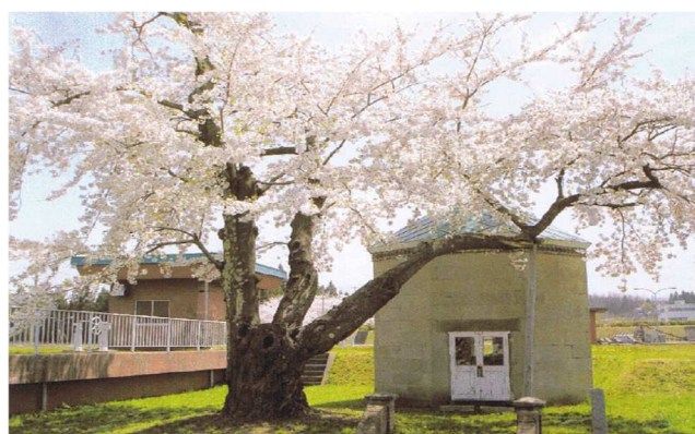
満開の桜に囲まれた横内浄水場の「旧配水井」。
