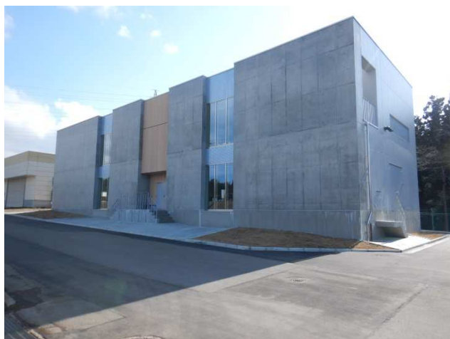
横内浄水場 紫外線・塩素処理棟
