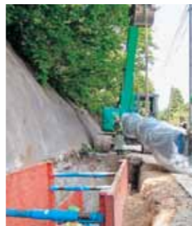
横内浄水場導水管二条化(耐震化)工事
