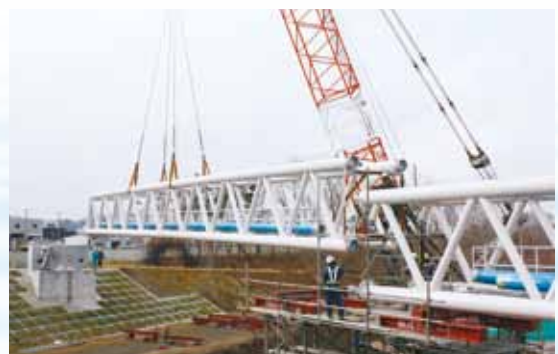
浅虫送水管耐震化事業（宮田水管橋の架設の様子）
