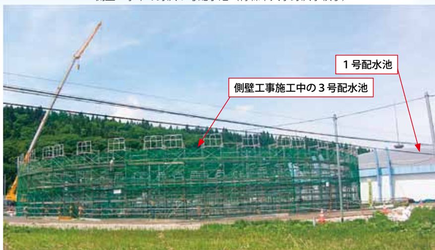
側壁工事中の野沢3号配水池（青森市大字野沢字横手）
