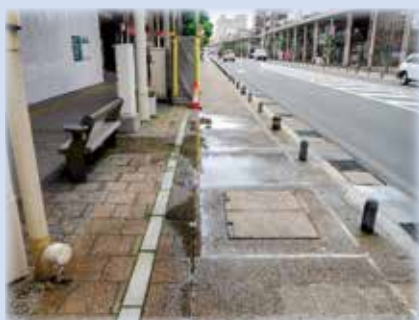
夏期漏水のイメージ写真
