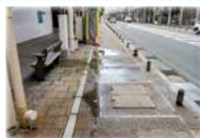
夏期漏水のイメージ写真
