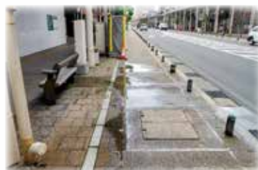
夏期漏水のイメージ写真
