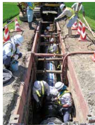
耐震管の布設工事
