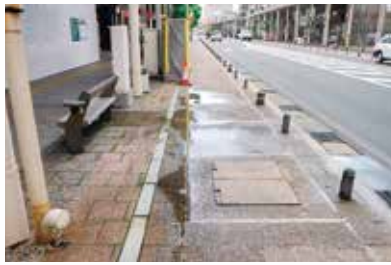
夏期漏水のイメージ写真
