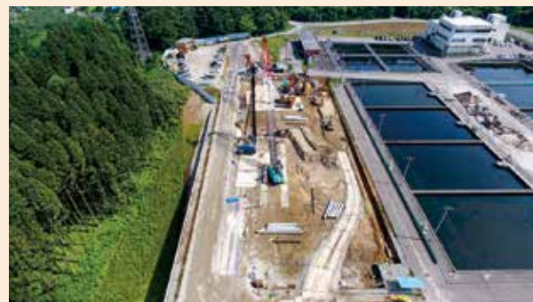
新しい沈殿池の基礎工事の状況（上空から）
