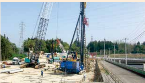
新しい沈殿池の基礎工事の状況（地上から）
