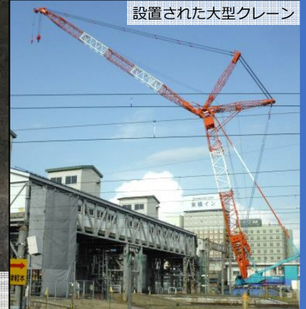
荷物搬送用通路エレベーター棟の撤去工事（青森駅東口）
