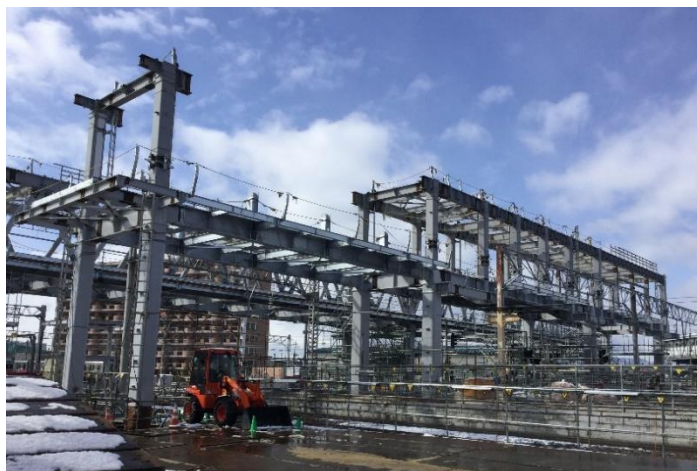
架設中の駅乗り換えご線橋（鉄骨）（駅構内）
