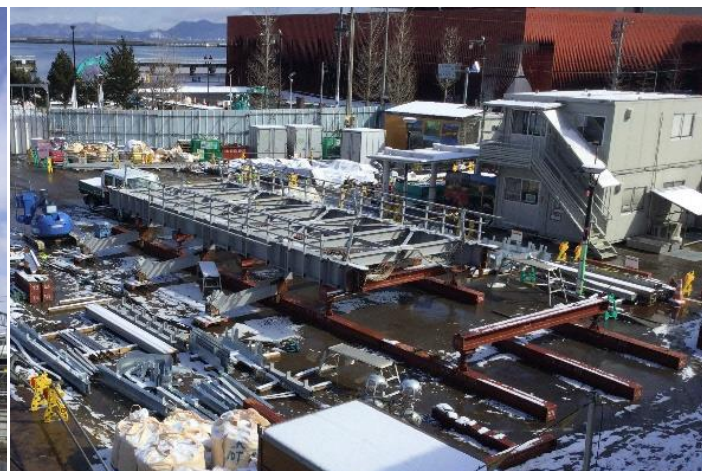
組立中の駅乗り換えご線橋鉄骨部材（駅東口）
