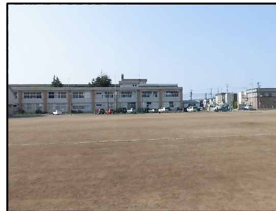
⑧から撮影した写真
